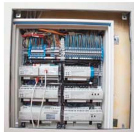
**Die gesamte KNX und EnOcean Verteiltechnik ist nicht sichtbar hinter einer extra dafür vorgesehenen Tür im Flur in der Wand untergebracht.**
