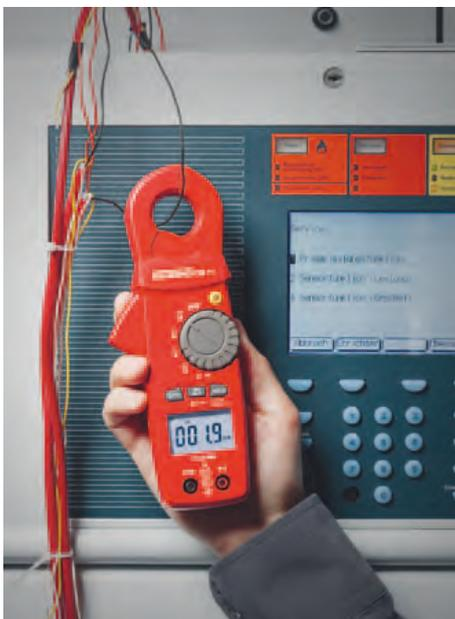
Eine vom VdS anerkannte Brandmelde- und Einbruchmeldeanlage muss bei Netzausfall uneingeschränkt einsatzfähig bleiben. Sobald ein Netzausfall vorliegt, übernehmen permanent geladene Akkus die sichere Bereitstellung der Versorgungsspannung.
