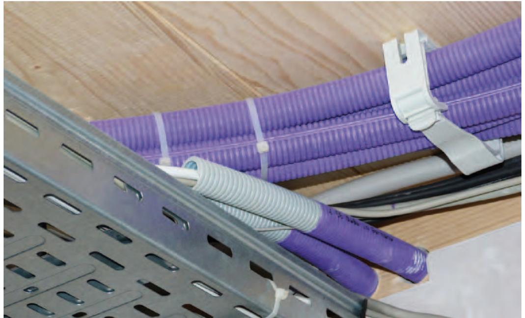
**Das Multifunktionsrohr ermöglicht eine saubere Installation von Daten- und Energieversorgung.**
