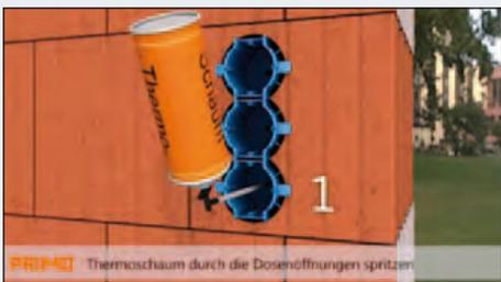
**Das Montagevideo zeigt die Schritt-für-Schritt-Anleitung für die Installation mit der Thermdose und dem Thermoschaum**
