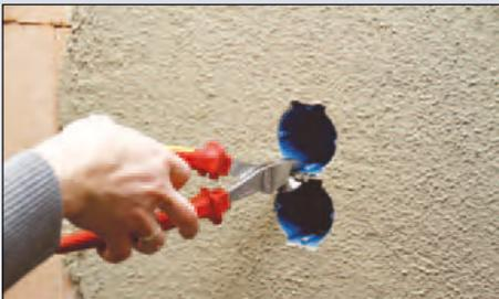
**Der Verbindungssteg zwischen den einzelnen Thermodosen kann nach dem Verputzen herausgetrennt werden**
