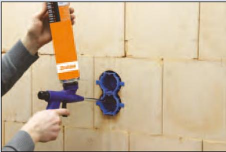
**Die Kombination aus Thermdose und Thermoschaum von Primo bringt viele Vorteile mit sich: schnelle Montage, Schall- und Vollwärmeschutz sowie Winddichtigkeit**
