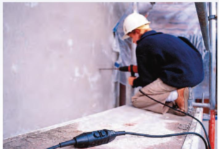
**Der PRCD-S erkennt Fehler in der Festinstallation und schützt den Anwender vor Elektrounfällen (Bilder: Heinrich Kopp GmbH)**
