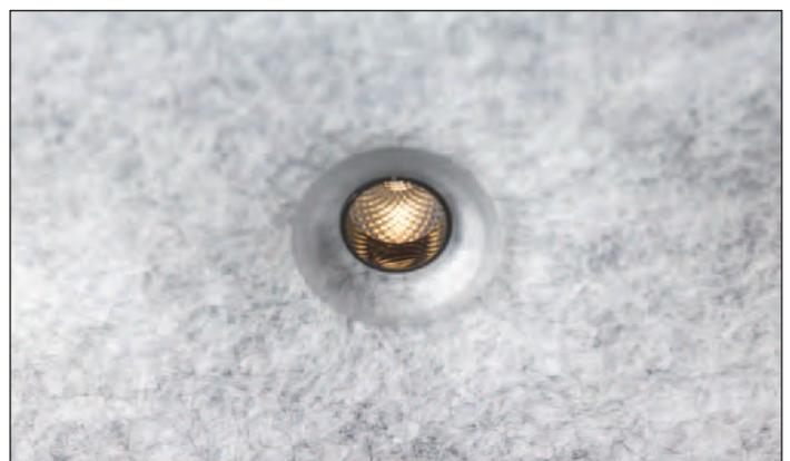
**Präzision und eine hohe Detailqualität zeigt die in das Vlies eingelassene Hochleistungs-LED (Durchmesser 8 mm), die auf den ersten Blick kaum wahrnehmbar ist (Foto: Frank Ockert)**
