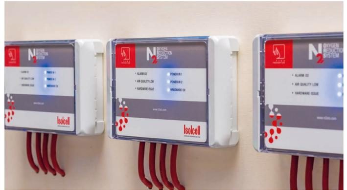
**Die verschleißfreien, hocheffizienten optischen Sensoren erfassen die Sauerstoffkonzentration im Schutzbereich punktgenau**
