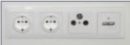
**Bild 2: Doppelsteckdose mit optischem Unterputz-Switch**
