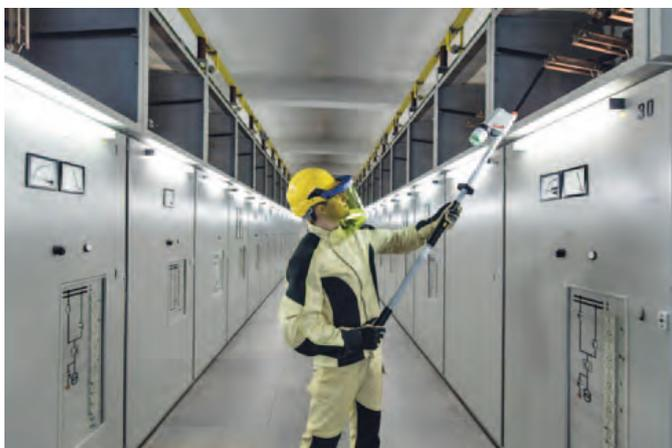
Die neuen Spannungsprüfer der Baureihe PHE4 von Dehn + Söhne
